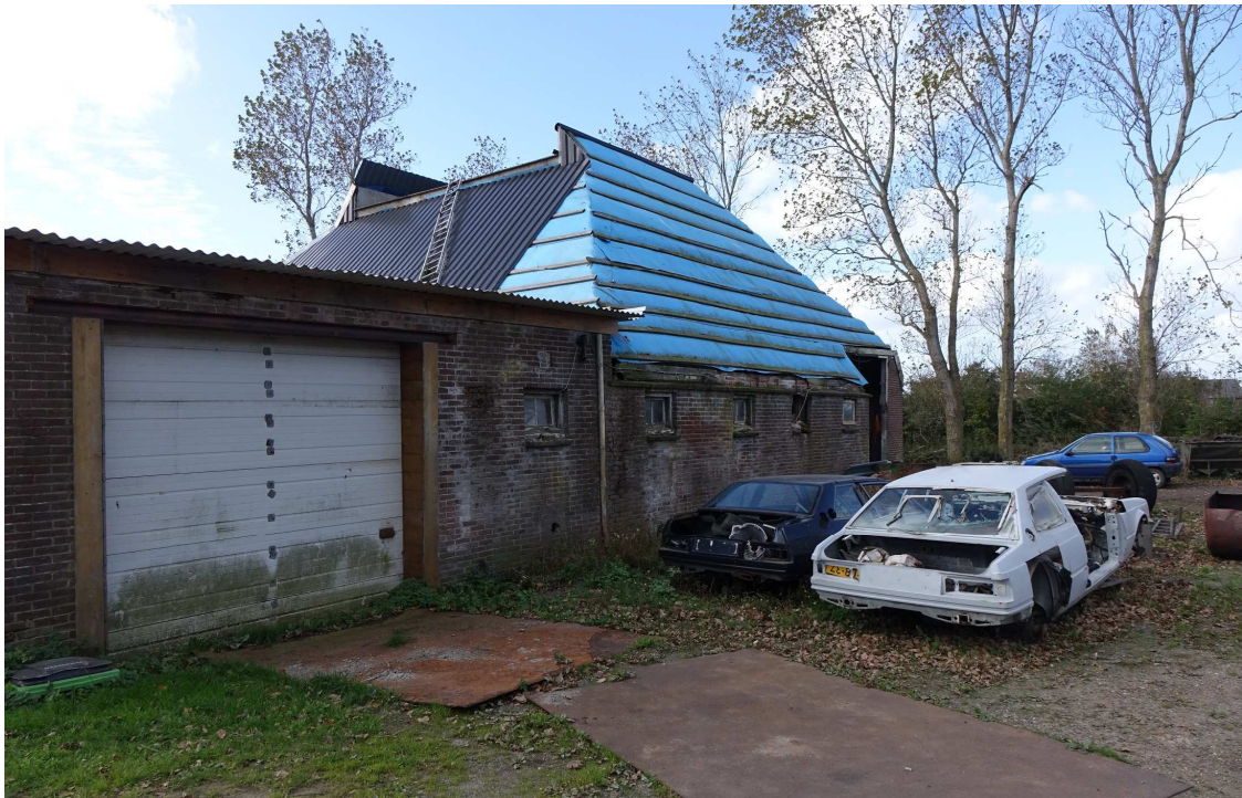
Figuur 2. De te slopen stolp met aanbouw op het garagebedrijf aan de Zuiderweg 2 te Anna Paulowna
