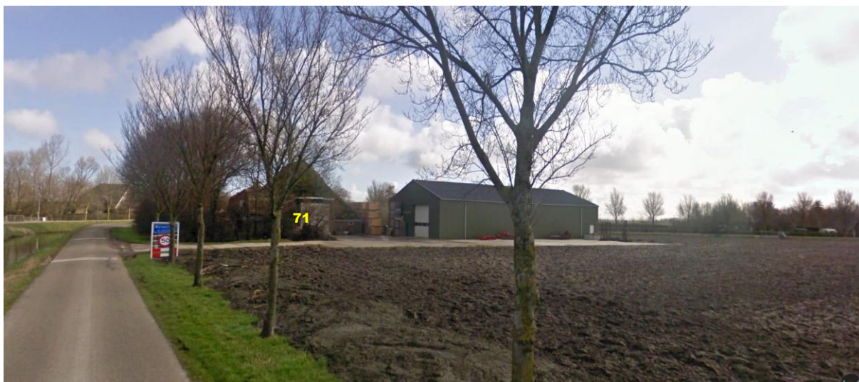
Afbeelding 20. locatie bedrijfswoning (BW) gezien vanaf de zuid Zijperweg
