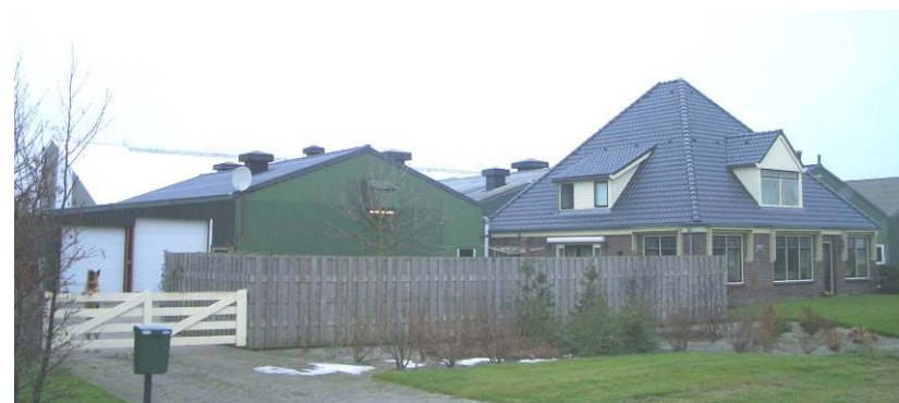
Geen samenhang van de bouwmasa's op het erf
