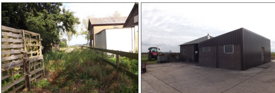
Figuur 7. Locatie nieuwe oprit (links) en te slopen bebouwing (rechts)
