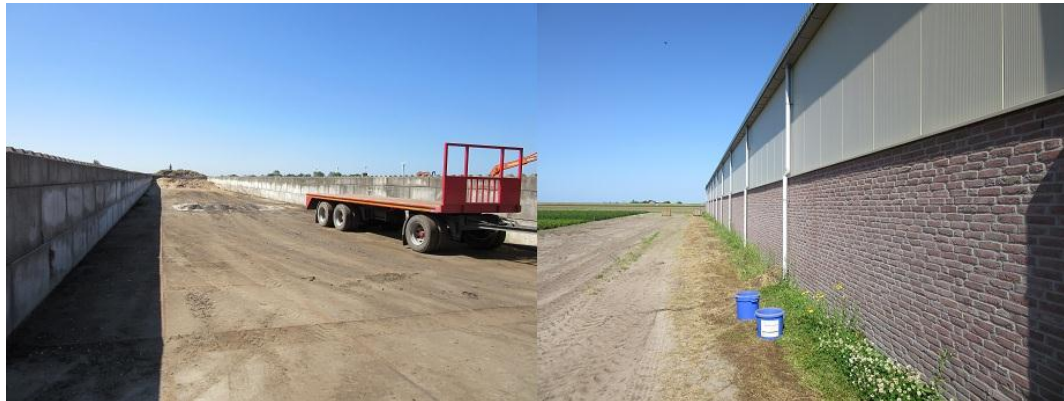
Figuur 5.2. Impressie plangebied 2. Links: betonnen bak voor opslag organisch materiaal. Rechts: bebouwing.
