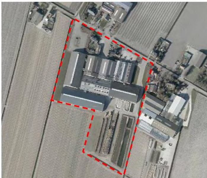
Afbeelding 1: overzicht bedrijfsbebouwing W. van Lierop & Zn B.V. in rood kader, inclusief de waterbassins en grondopslag (bron: Globespotter)
