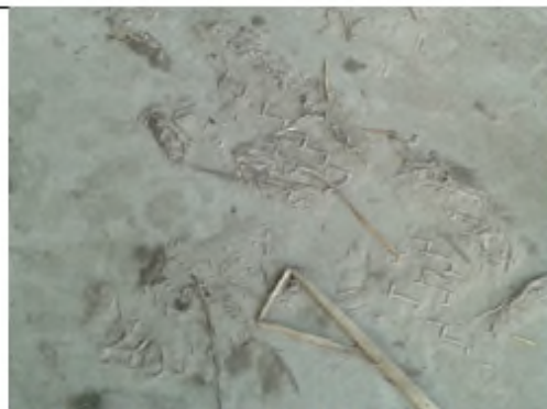
Foto 1: resten van plantmateriaal in bedrijfsgebouwen
