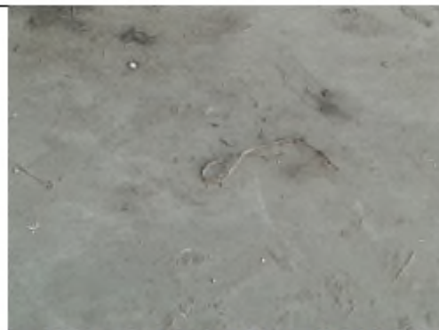
Foto 2: resten van plantmateriaal in bedrijfsgebouwen
