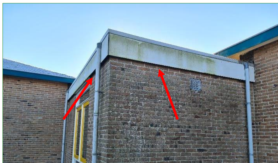
De openingen onder de houten dakrand (rode pijl) van de bebouwing geven mogelijk toegang tot voor vleermuizen geschikte achterliggende ruimtes.
