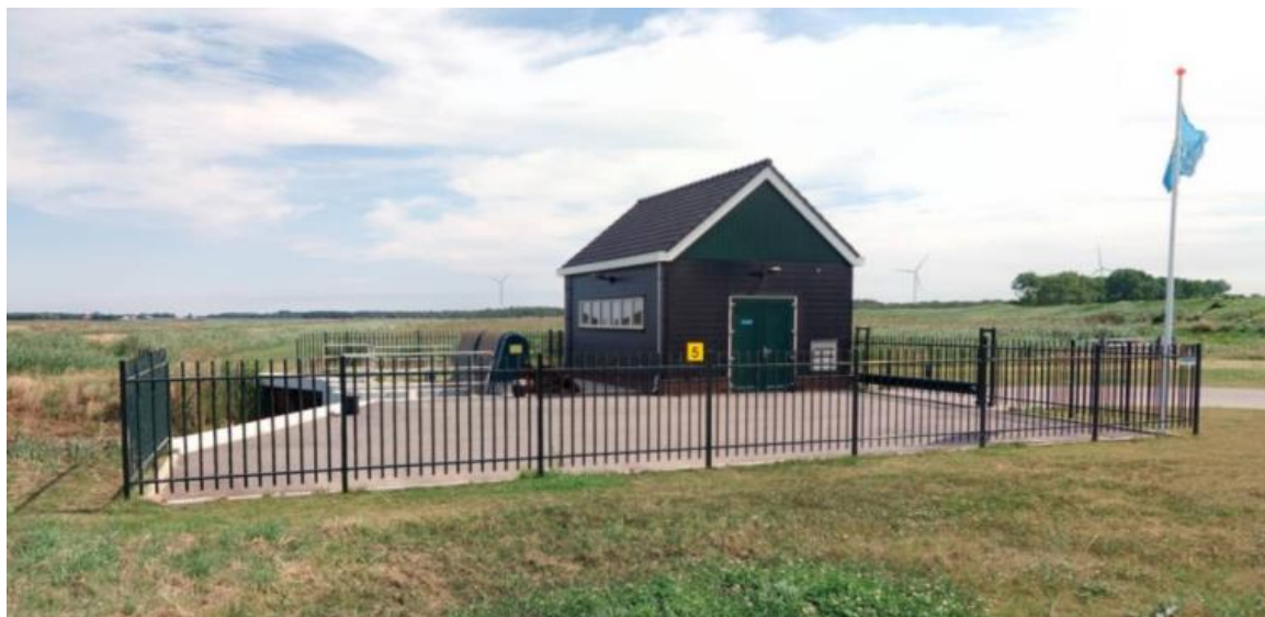
afb.1 Referentie: gemaal Waard-Nieuwland (bron: HHNK)
