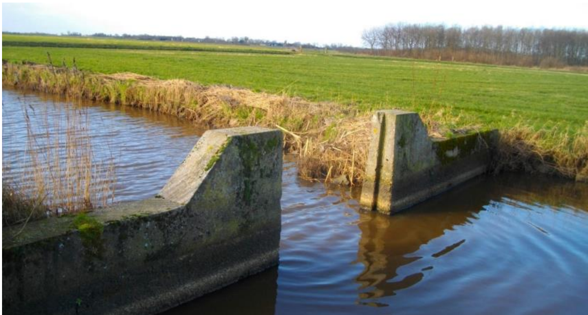
afb.12 Te verwijderen schotbalkstuw
