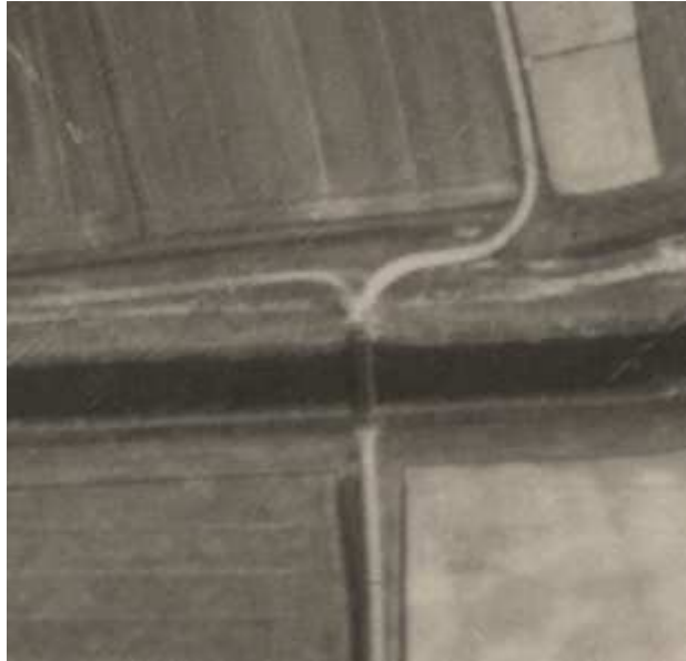
Figuur 11. Bij de brug direct ten westen van het schijn/hulpvliegveld lijkt het brugdek te zijn verwijderd voor 19 april 1945. (Luchtfotonummer 3053).
