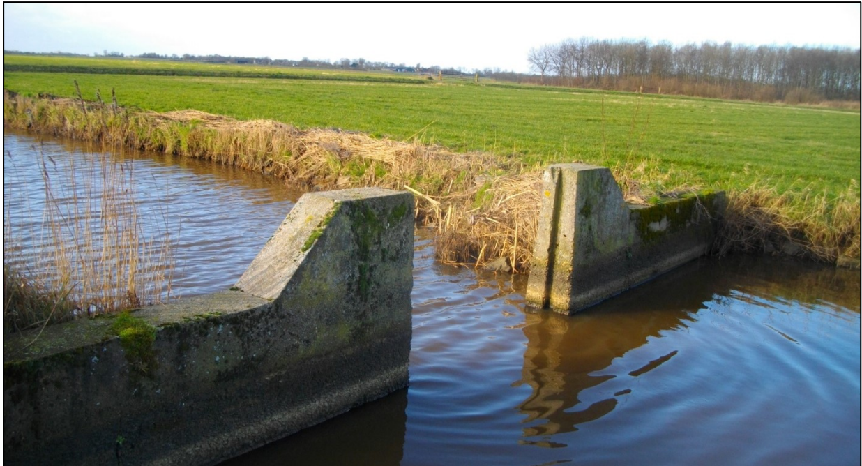
Afbeelding 15: te verwijderen schotbalkstuw
