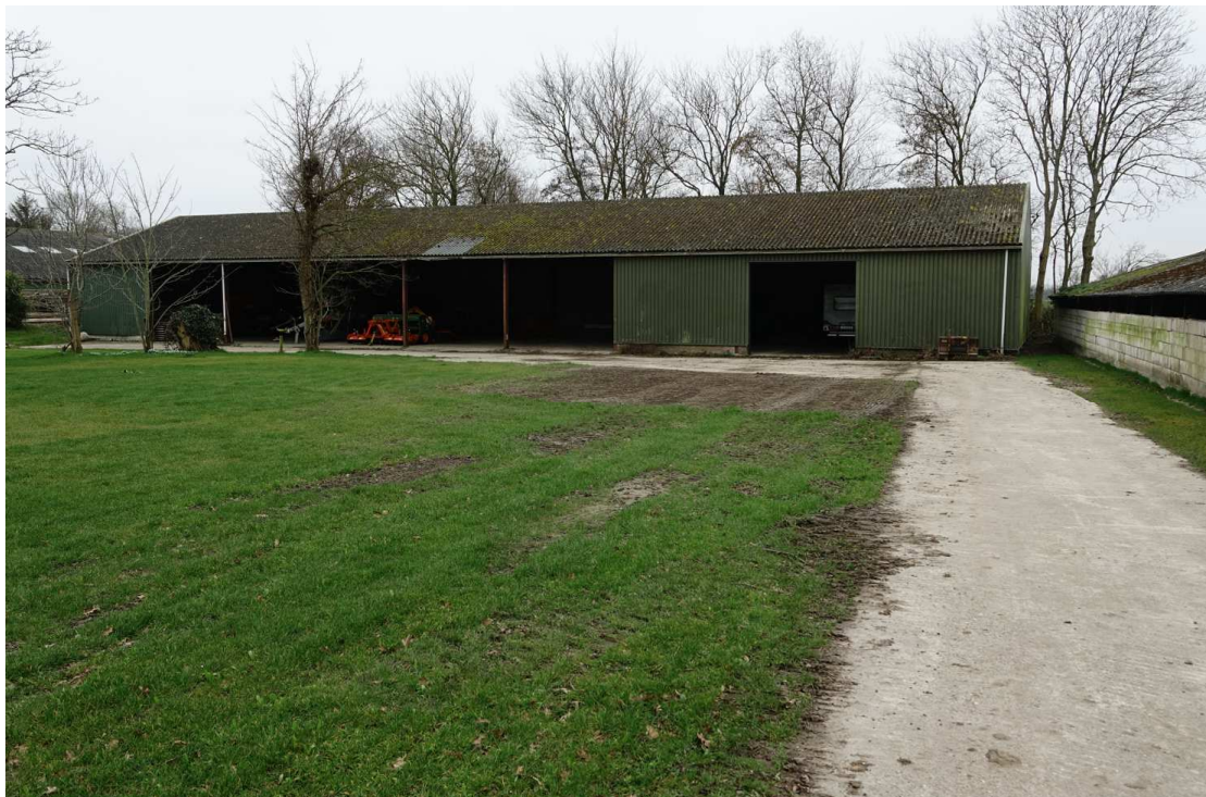
Figuur 2. De te slopen kapschuur met linksachter een deel van de loopstal en rechts de oude kippenstal.
