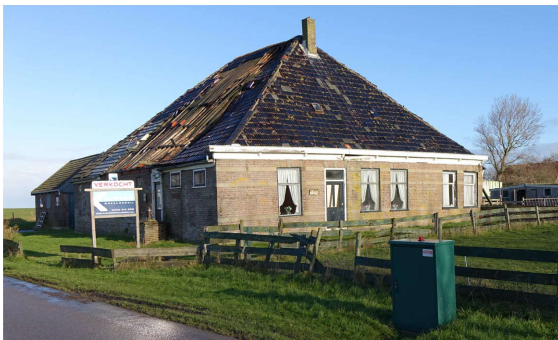
Figuur 2. De te slopen stolp met op de achtergrond enkele opstallen.
