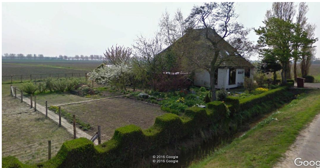
afb. 4 De planlocatie met de recent gesloopte woning
