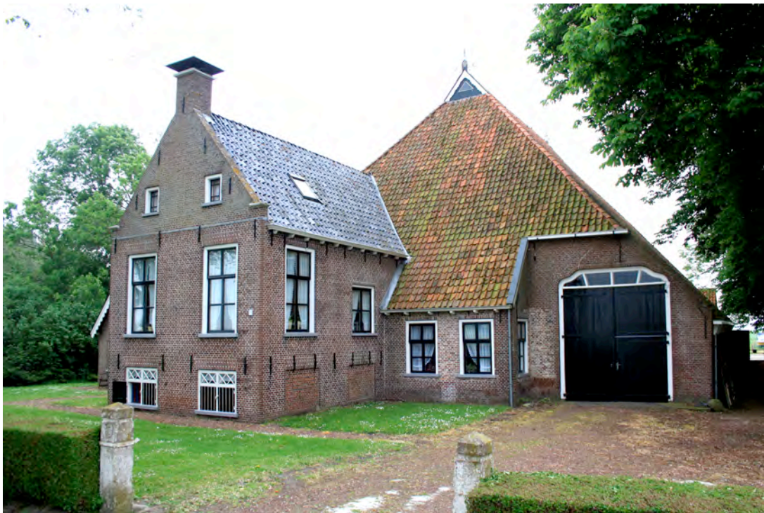
Kop-romp boerderij aan de Wijckelerweg te Sloten
