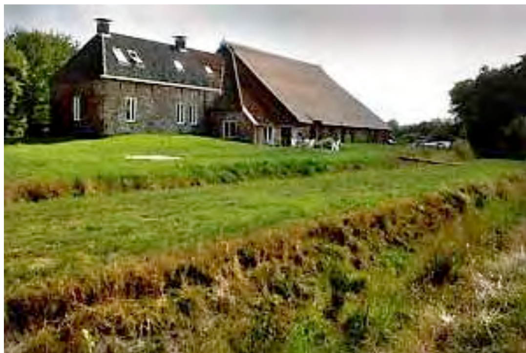
Zaalsluis Allemastate te Oudwoude
