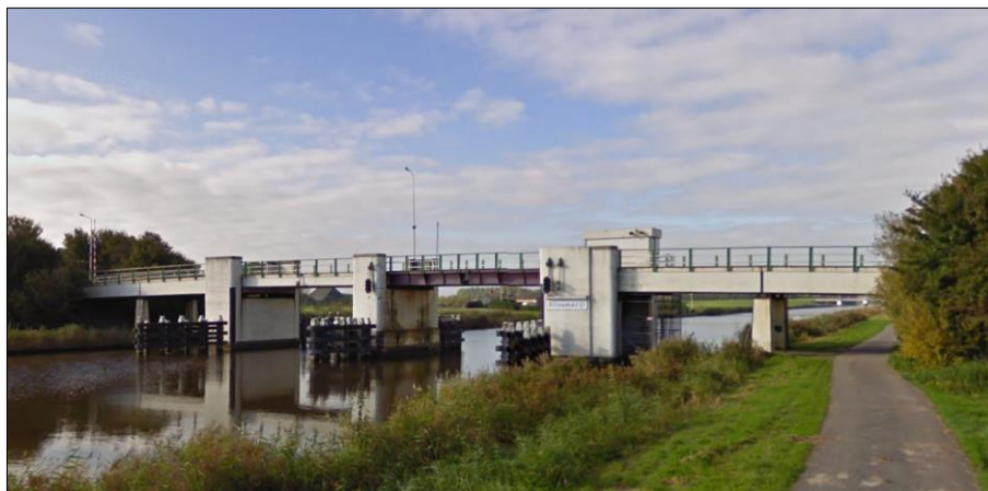
Figuur 2. Bestaande basculebrug bij Ritsumasyl (bron: Google Streetview)
