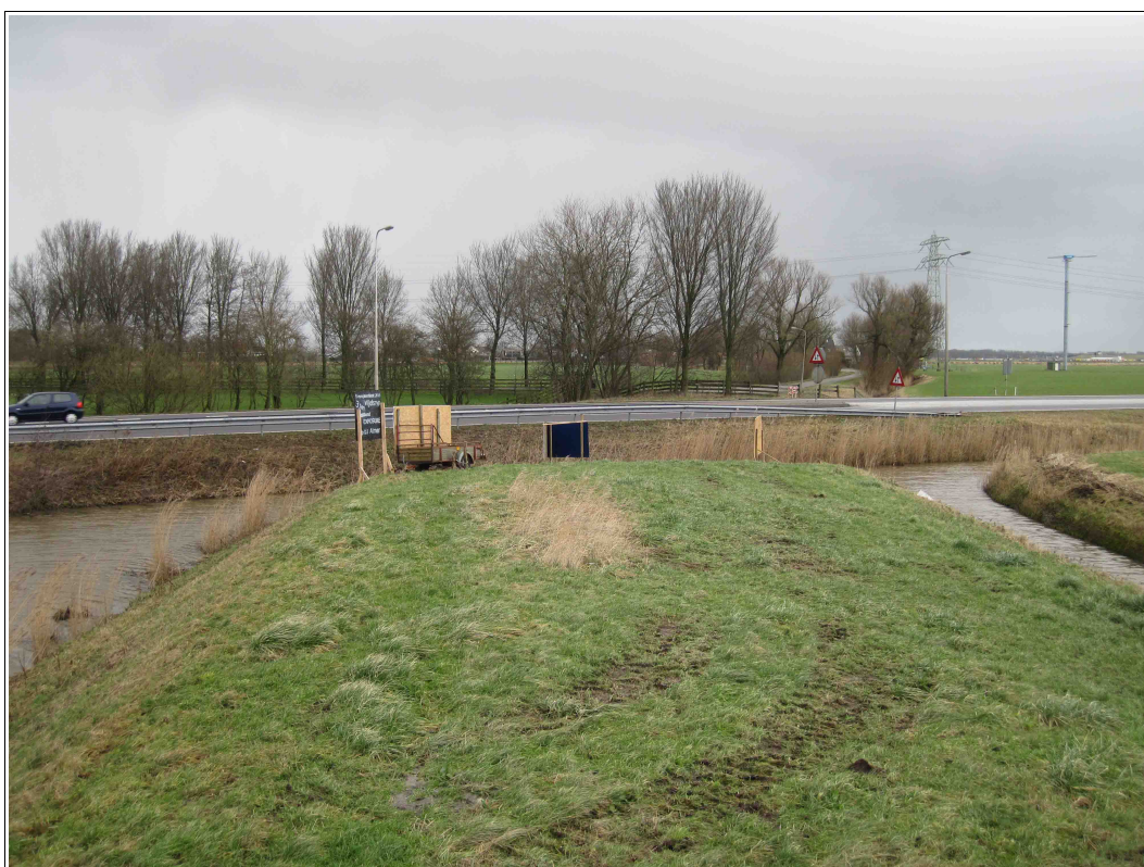
Figuur 2: Deinum, N31: foto van locatie 4 genomen in noordelijke richting. Op deze locatie is een fietsonderdoorgang gepland.
