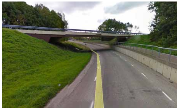
Autobrug in N31 over Hegedyk
