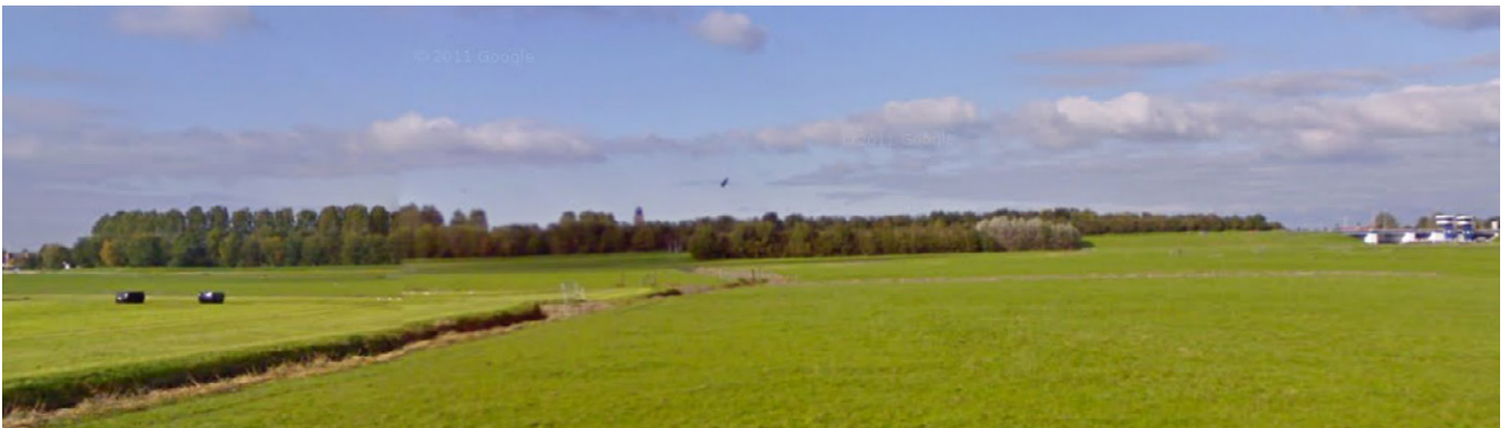
Zicht op de oostrand van Deinum: verscholen ligging achter het stevig beplante talud van de N31
