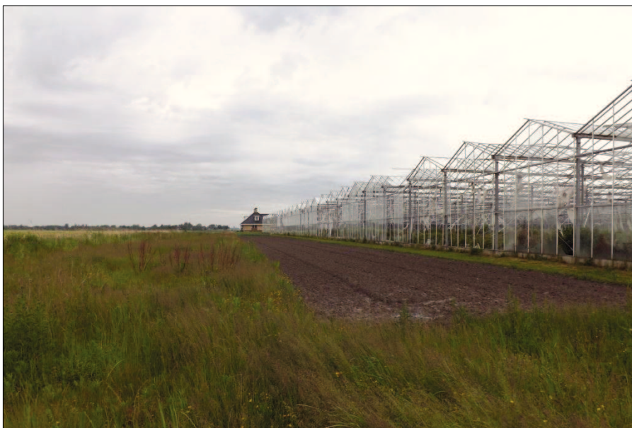
Figuur 7. Westzijde plangebied vanuit het zuiden
