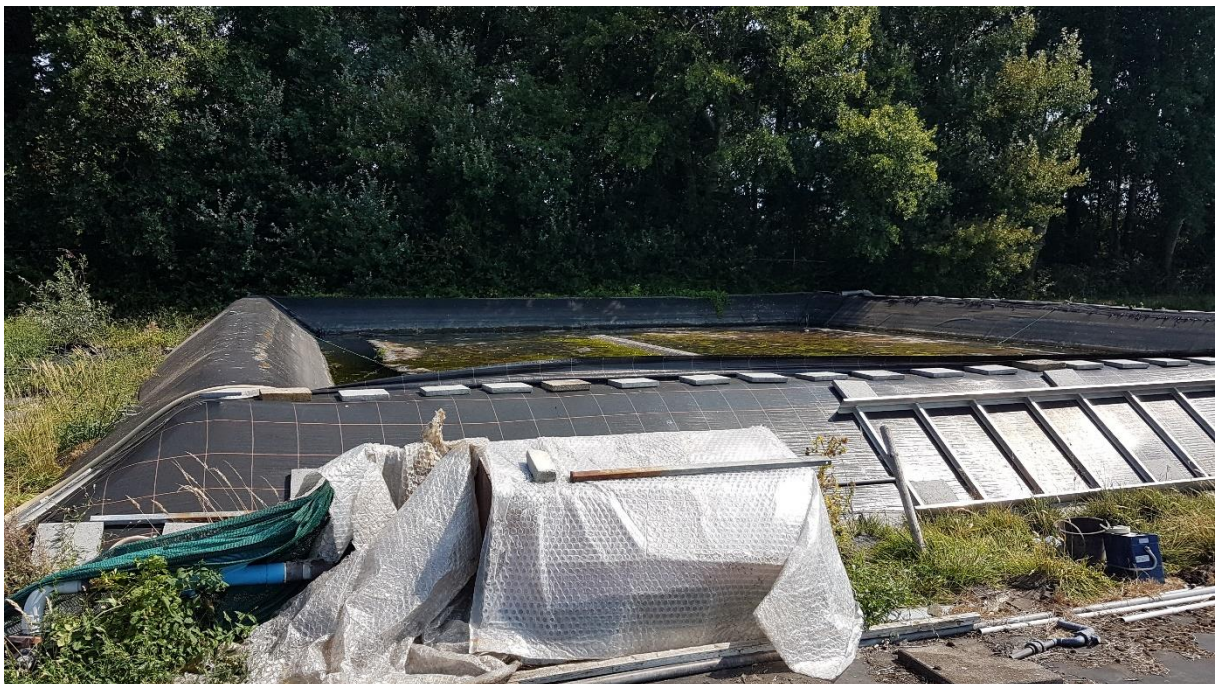
Waterbassin aan de noordoostzijde van onderzoekslocatie, kijkrichting oost
