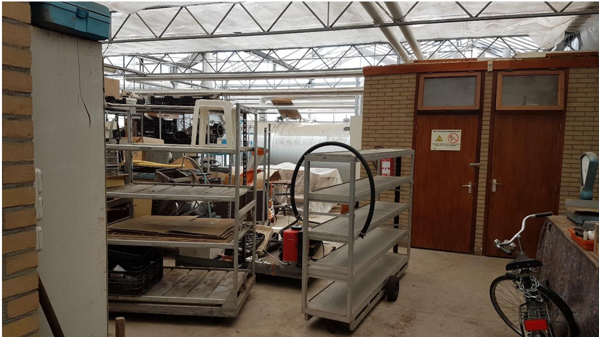
Onderzoekslocatie, bedrijfsruimte, kijk op ketelhuis, kijkrichting zuidoost
