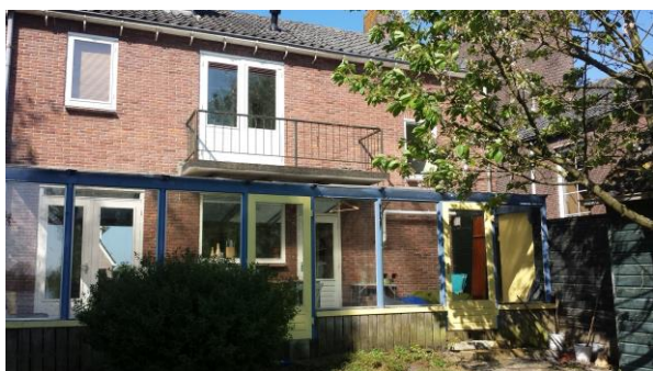
Achterzijde woning met serre
