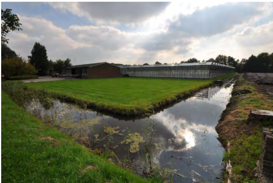
Kassencomplex, gezien vanaf de wegzijde en het buurperceel Gageldijk 6
