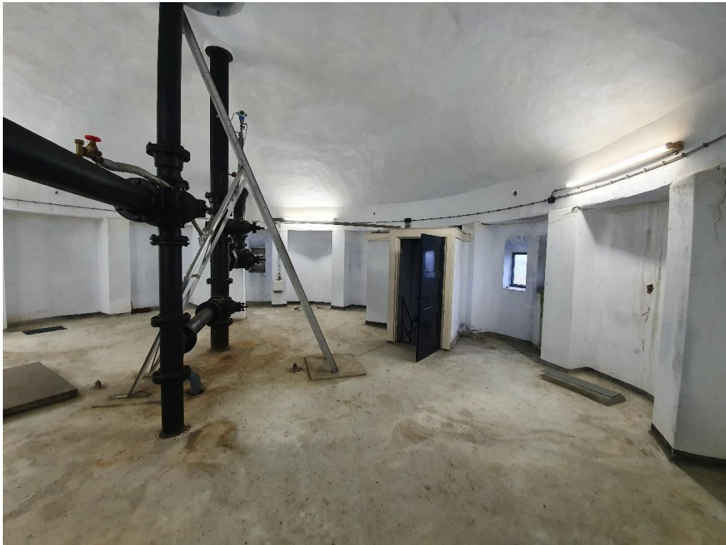
Figuur 3 Dakruimte van de watertoren waar alle buizen welke voorheen gebruikt werden voor waterverplaatsing afgesloten zijn.
