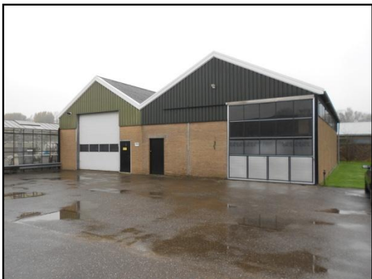
in het gebouw links is de onderhouds en reparatieservice voor caravans gevestigd
