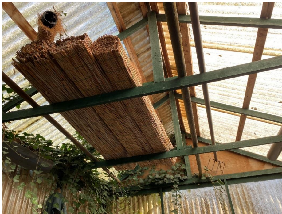
Figuur 2.3 binnenkant dak schuur
