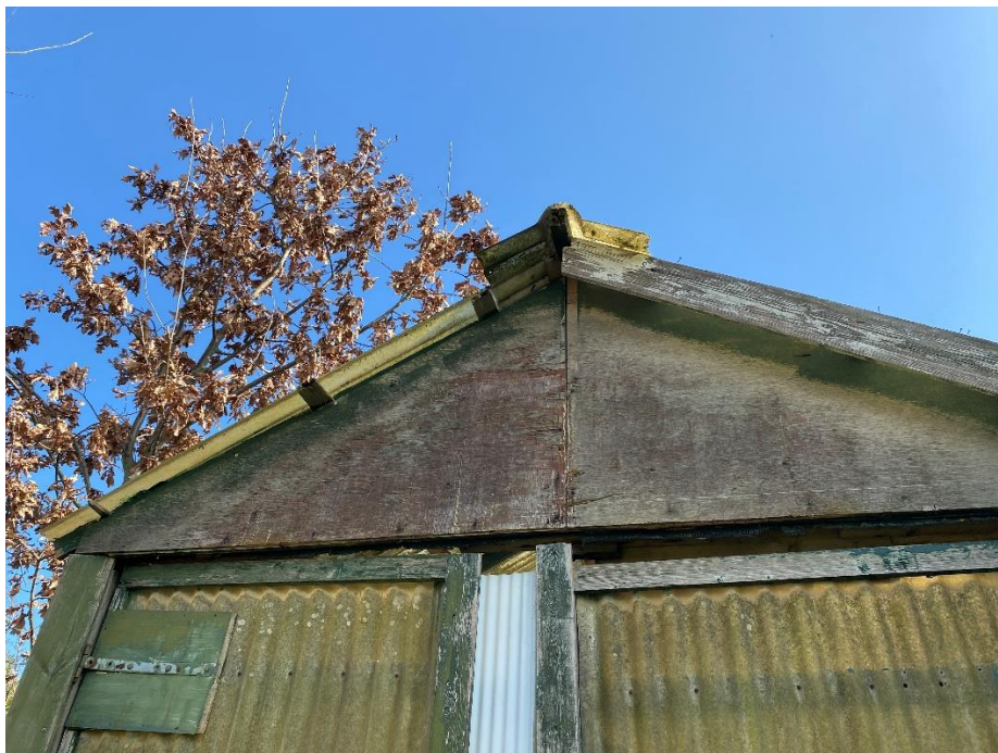
Figuur 2.2 dak schuur
