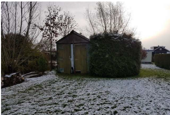
Foto 1: schuur noordwestzijde (vanaf westzijde)
