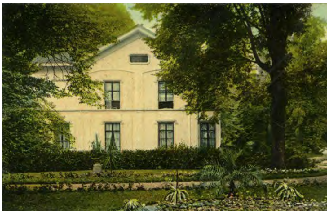
Ingekleurde foto Mid- denhoek. Zicht op de linker zijgevel vanaf de Rijksstraatweg met op de voorgrond het hoofd- pad van de toerit naar de voordeur. (1910- 1915)
