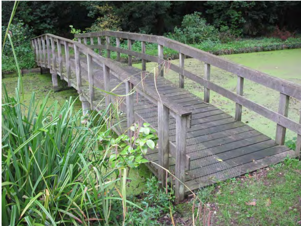
De houten brug over de noordvijver, gezien vanaf het noordoosten.
