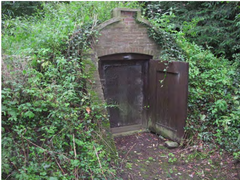
Toegang tot de appelkelder, gericht op het zuidzuidwes- ten.
