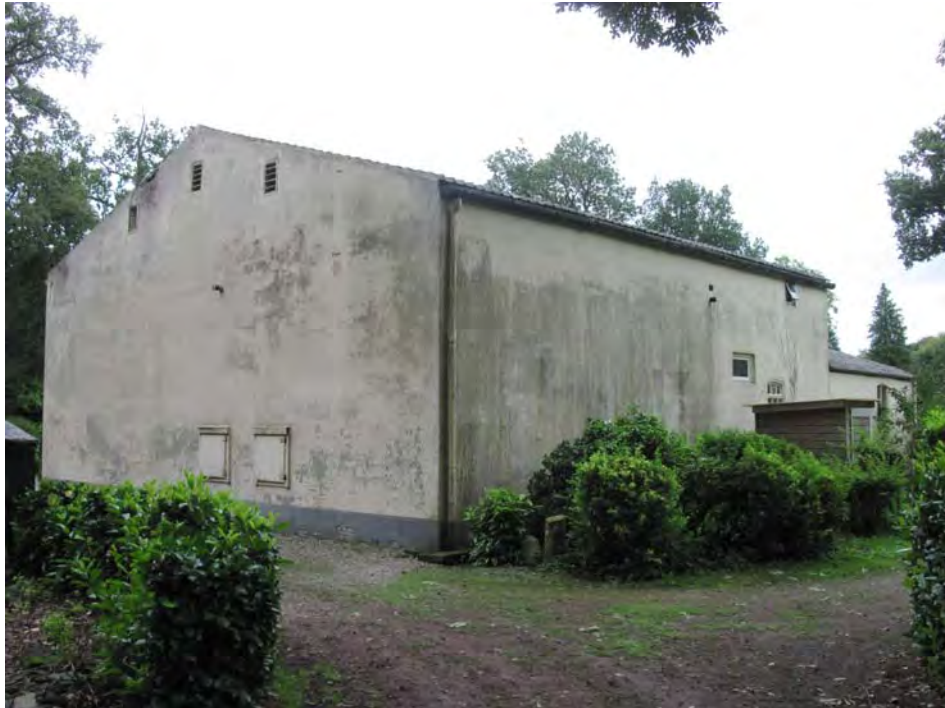
Koetshuis gezien vanaf het noorden
