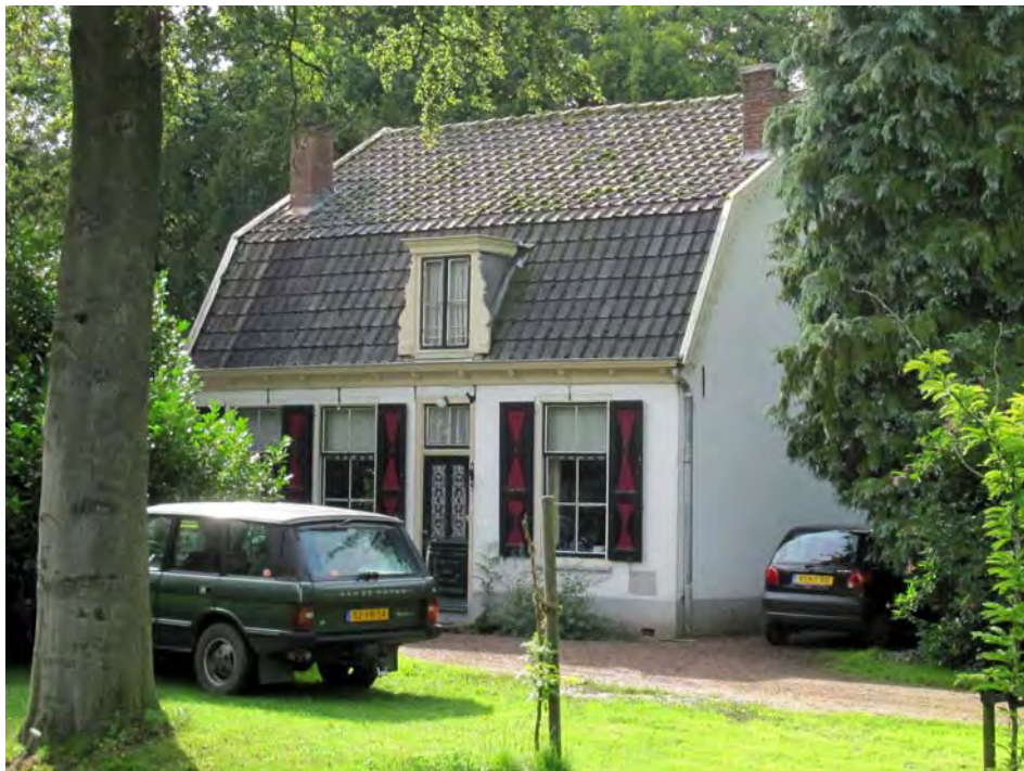
Vooraanzicht van de zuidelijke dienstwoning gezien vanaf de weg (noordoost)
