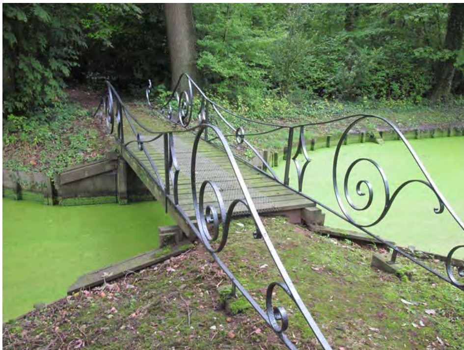
Sierbrug gezien vanaf het noordoos- ten.
