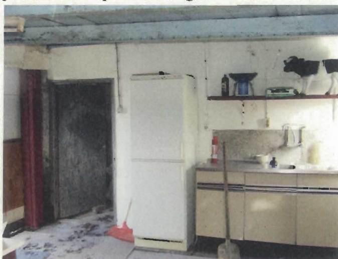
Keuken zomerhuis; geen asbest aangetroffen.
