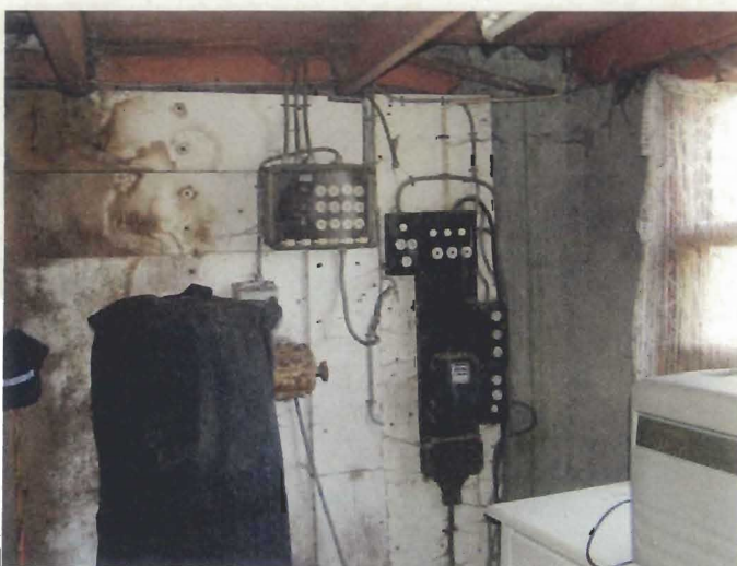
Elektra installatie zomerhuis; geen asbest aangetroffen.
