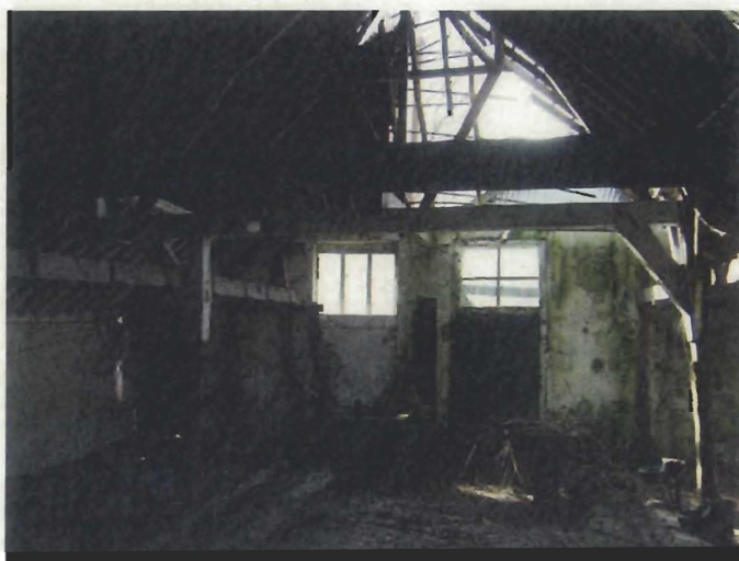
Deel woonboerderij; geen asbest aangetroffen.
