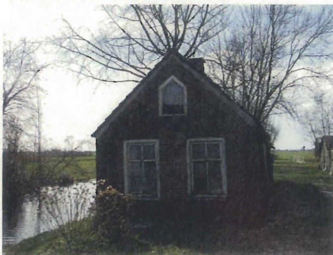
Vooraanzicht zomerhuis; geen asbest aangetroffen.
