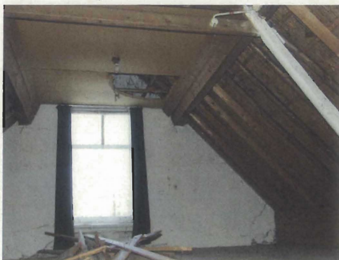
Verdieping woonboerderij; geen asbest aangetroffen.
