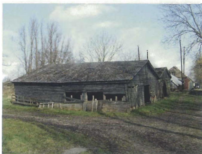
Schuren voorzien van asbest golfplaat.
