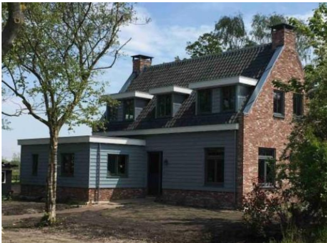
Voorzijde links van de woning, gezien vanaf Portengen 8a
