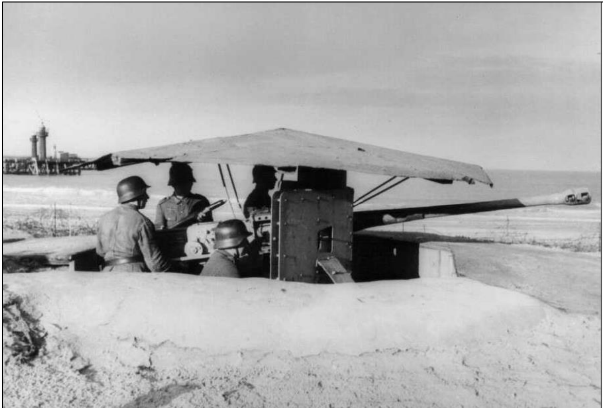
Figuur 74. Voorbeeld van een Tobroekstelling aan de kust, onderdeel van de Atlantikwall. Bovenstaande foto is niet ter plaatse van het projectgebied genomen. Bron: Thorsten Heber, Der Atlantikwall 1940-1945, Die Befestigung der Küsten West- und Nordeuropes im Spannungsfeld nationalsozialistischer Kriegsführung und Ideologie (Bonn 2003).
