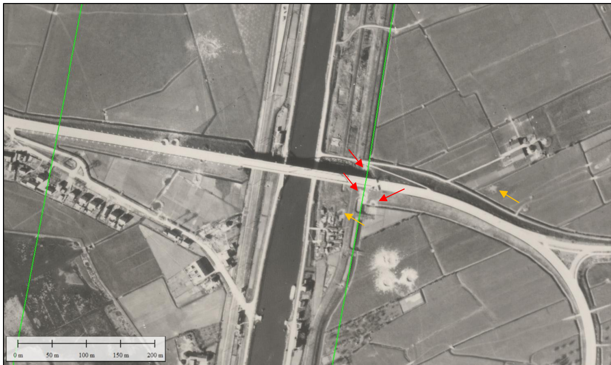
Figuur 46. De brug te Loenersloot op 8 april 1945. Er heeft inmiddels een tweede aanval plaatsgevonden, ditmaal met een kleiner kaliber afwerpmunitie. Oranje pijlen geven verstoringen aan waarvan niet met volledige zekerheid valt te zeggen of het kraters zijn. Op foto's van latere datum zijn geen nieuwe verstoringen waargenomen.
