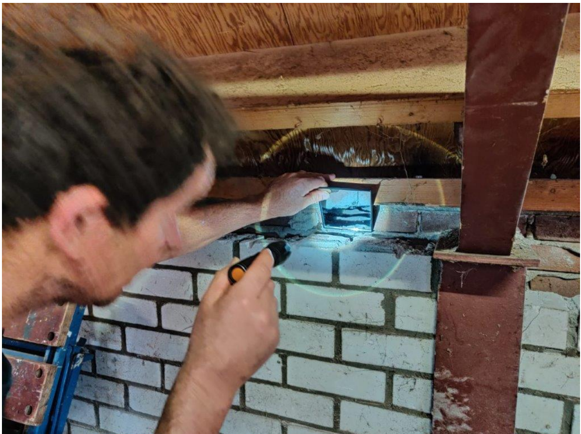
Spouw is aan de bovenzijde volledig open.
