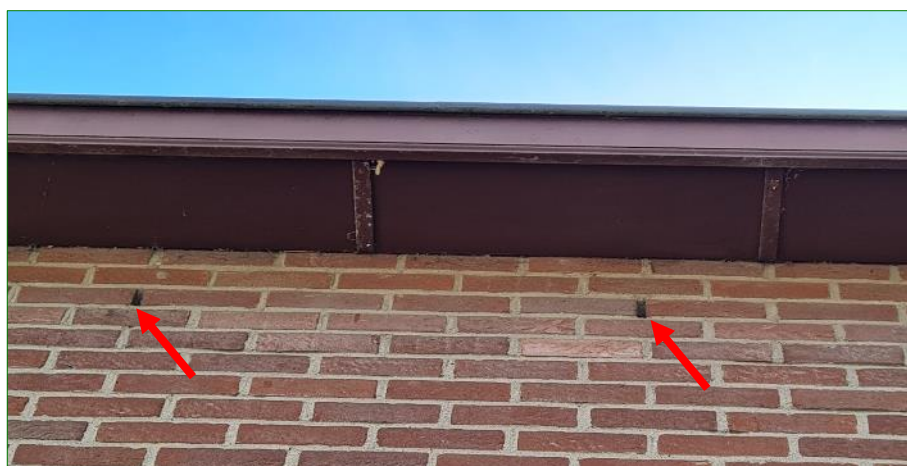
De openingen in de spouwmuur (rode pijlen) geven mogelijk toegang tot voor vleermuizen geschikte achterliggende ruimtes.
