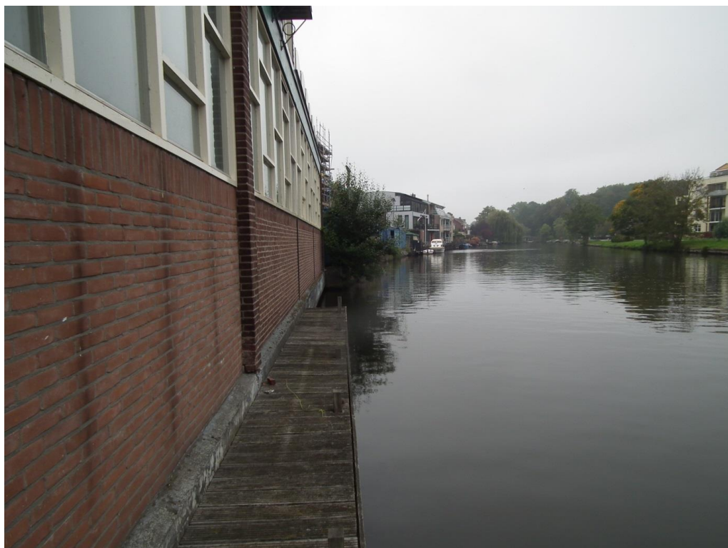
Figuur 2 De locatie betreft een bedrijfspand en verharding en wordt begrensd door de Vecht. Tevens wordt thans aan de noord- en zuidzijde nieuwe bebouwing gerealiseerd.
