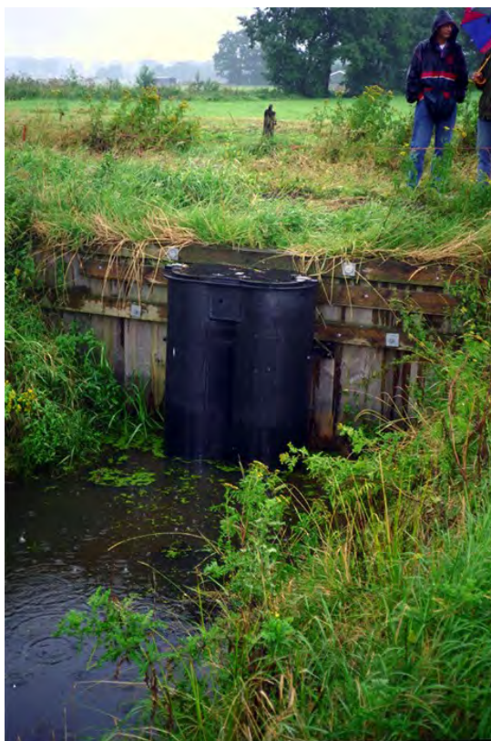
Figuur 5.9: Afbeelding stuw met vlotterunit (bron www.kwtgroup.nl )
