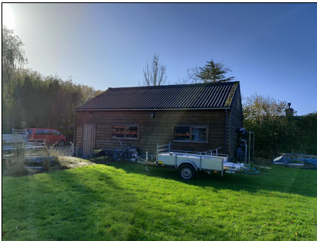
Figuur 2 De te saneren grote schuur op de planlocatie.
