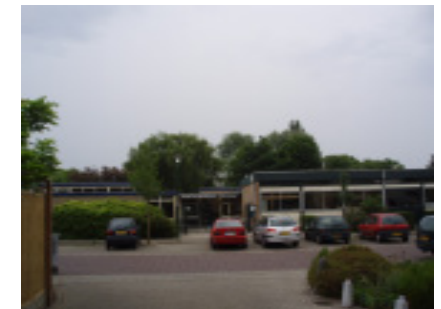
Niet structurerende bebouwing
