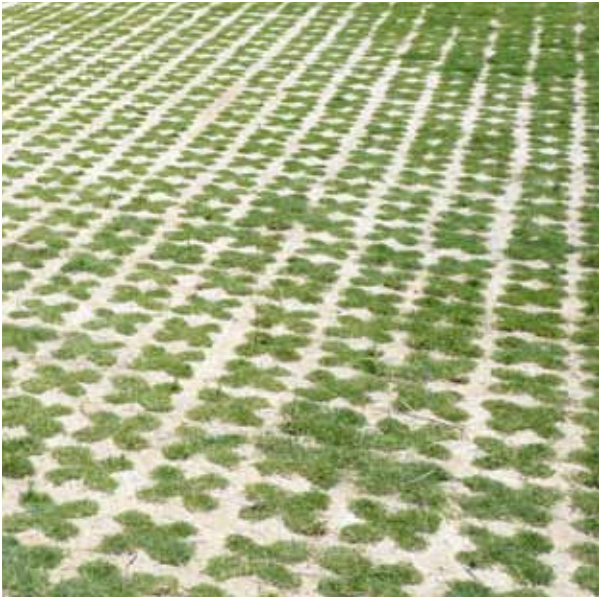
Grasbetonstenen pad naar ijsbaan
