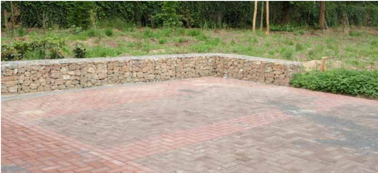
Schanskorven als afscheiding ontvangstruimte
