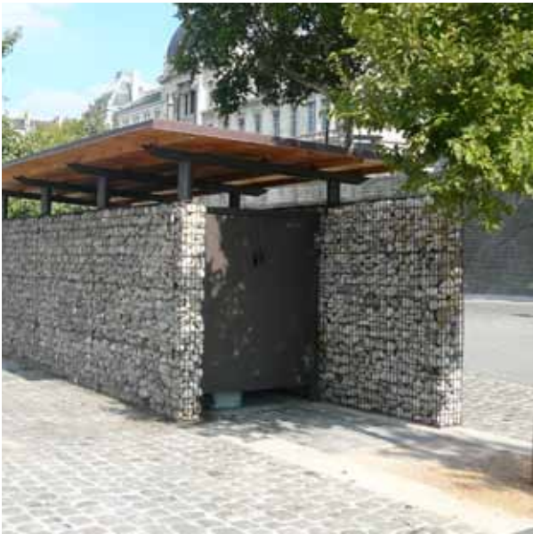
Containers kunnen worden ‘ingepakt’ met schanskorven
