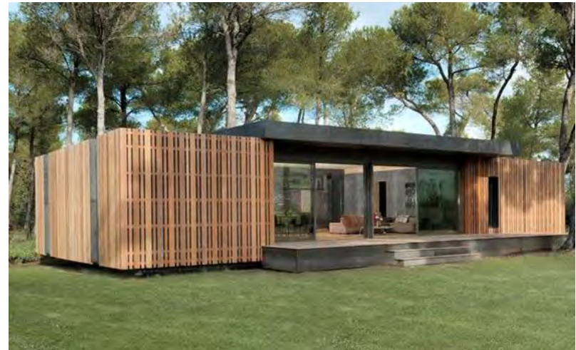
houten gevel, glas, verticaal hout, plat dak
