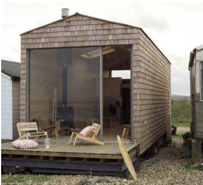
houten gevel, met houten shingles
