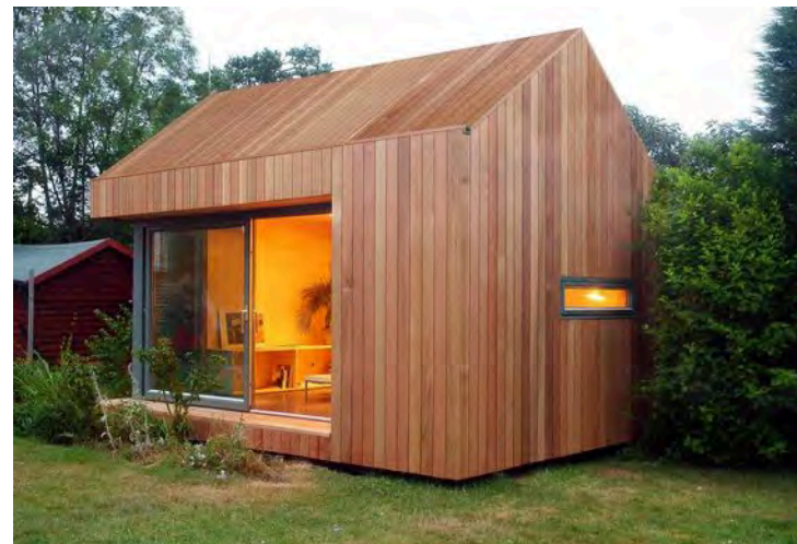
gevel en dak verticaal hout
