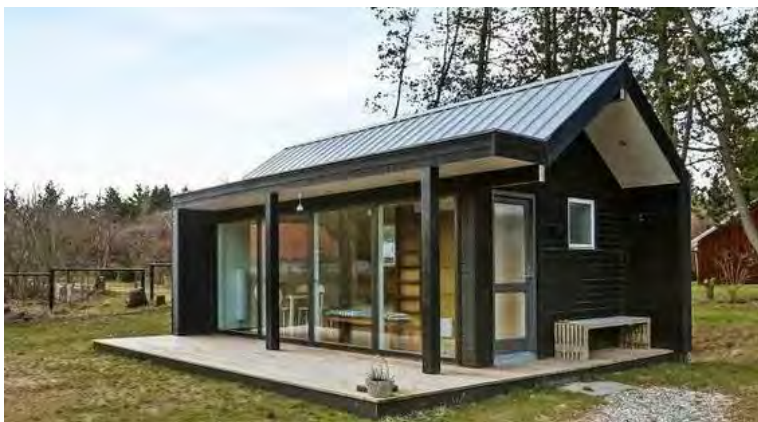
houten gevel en veranda aan lange gevel
