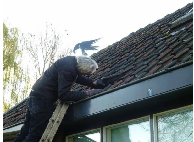
Figuur 7: Inspectie dak i.v.m. nesten Huismus
