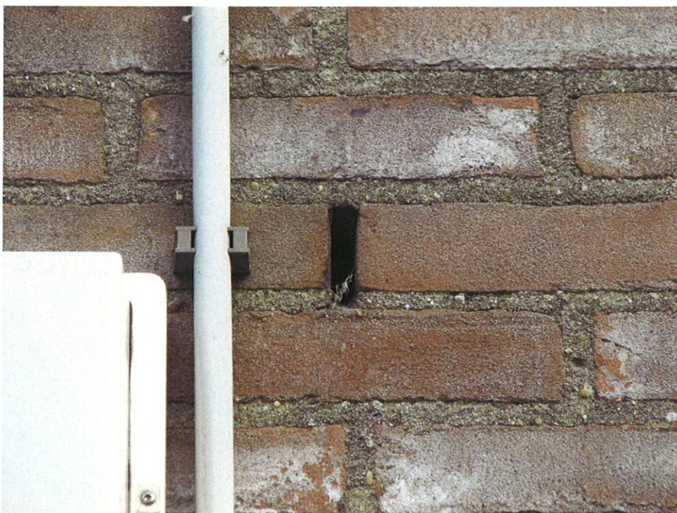
Foto 8: Spouwmuurventilatieopeningen vormen een mogelijke ingang voor vleermuizen.
