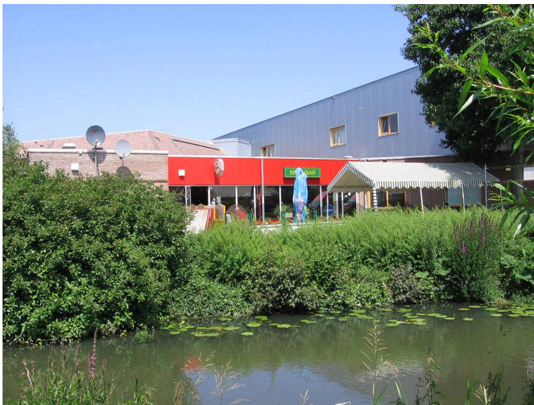
Foto 3dak recreatiebad, gevels sporthal en restaurant
