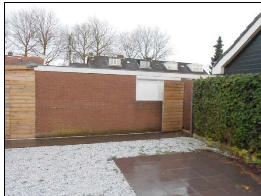
zijkant garage en links deel van de berging
