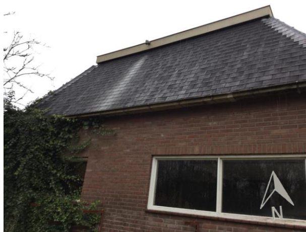
Foto 4: Dak van pand met ID: 0333100000016473 (kadaster)
