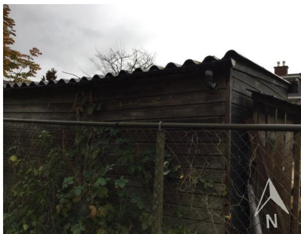
Foto 7: Dak van pand met ID: 333100000021099 (kadaster)
