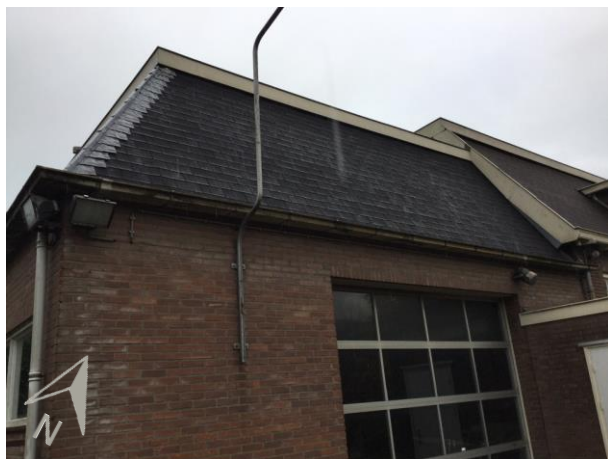
Foto 3: Dak van pand met ID: 0333100000016473 (kadaster)
