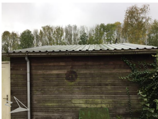
Foto 5: Dak van pand met ID: 0333100000017806 (kadaster)
