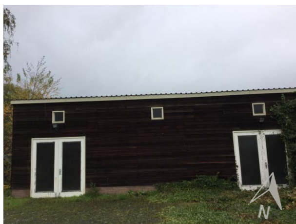
Foto 6: Dak van pand met ID: 1904100000041720 (kadaster)
