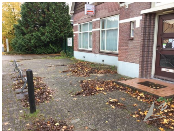
Foto 2: Zijaanzicht van de locatie van de voormalige ondergrondse tank
