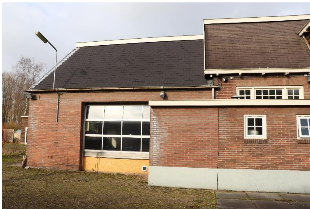
Figuur 2 De aanbouw met spouwmuur aan de achterzijde van het pand
