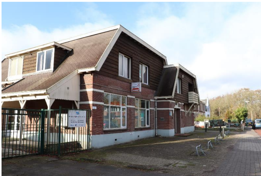
Figuur 1 De planlocatie is gelegen aan de Daalseweg 3 te Oud-Zuilen en bestaat deels uit een gemetselde muur zonderspouw met een zadeldak met bitumen dakbedekking en deels uit een gemetselde muur met spouw met zadeldak met bitumen dakbedekking en dakterras.
