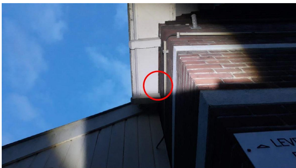
Figuur 3.3 Locatie van de zomerverblijfplaats van gewone dwergvleermuis aan de voorzijde van het kantoorgebouw (Foto: N. Schuurmans).
