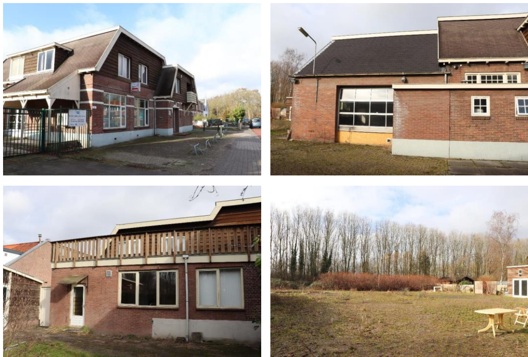
Figuur 1.2 De planlocatie bestaat o.a. uit een kantoorgebouw met een parkeerplaats (bron foto's: Schuuring, 2019).
