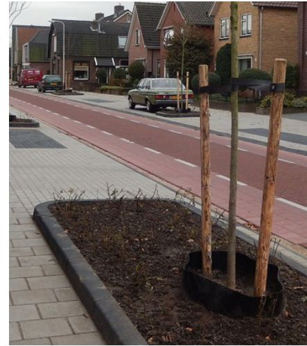
Parkeren op de stoep, tussen de boomvakken, ter plaatse van de Driehoekslaan
