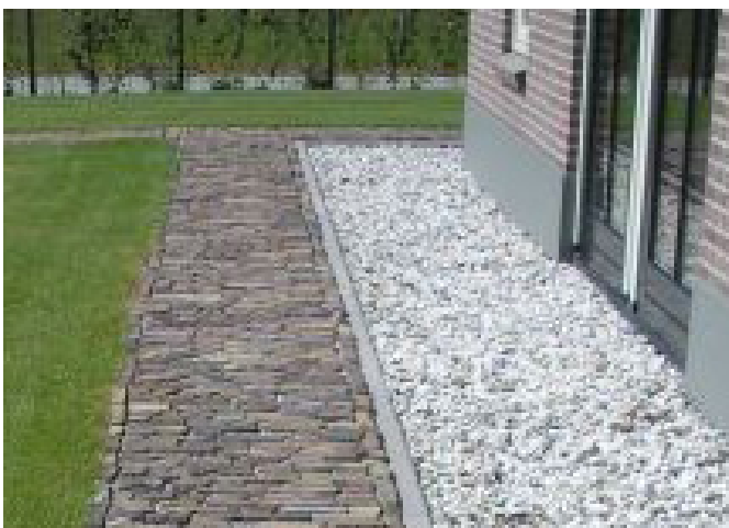
Paden van gebakken klinkers en/of grind
