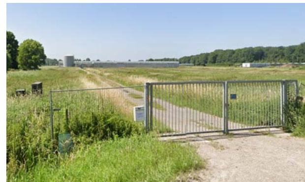
Zicht op entreeweg met te saneren kassencomplex vanaf Westbroekse Binnenweg
