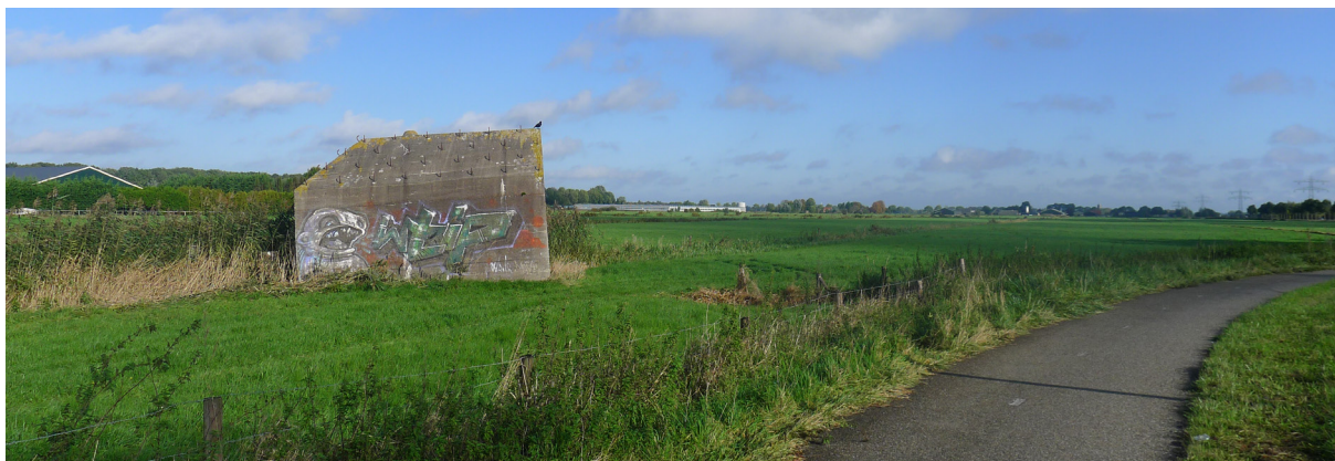
Zicht vanaf de Burgermeester Huydecoperweg, nabij fort De Gagel, richting de locatie. De kas op het zuidelijke perceel verstoort de openheid van de polder en de verboden kring.
