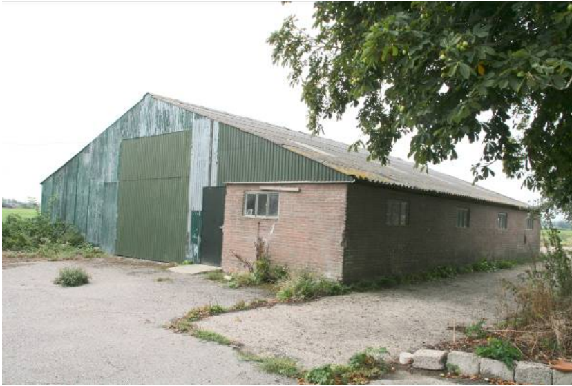
De veldschuur, gezien vanuit het noordoosten.
