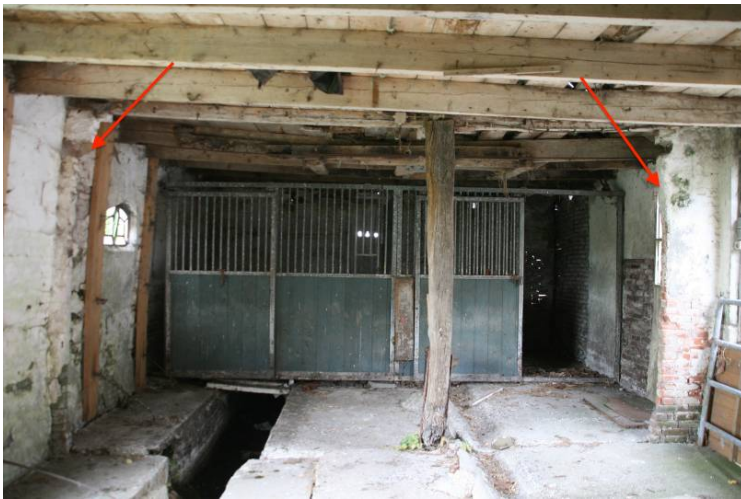
Het gedeelte van het zomerhuis achter de huidige bijkeuken, gezien naar het westen. De metalen schuifdeuren dateren waarschijnlijk uit de periode dat de boerderij diende als paardenstalling. Restanten van een dwarsmuur geven aan dat de huidige ruimte oorspronkelijk was onderverdeeld. De voergoot en de grup geven aan dat de huidige ruimte geheel als stal heeft gediend.
