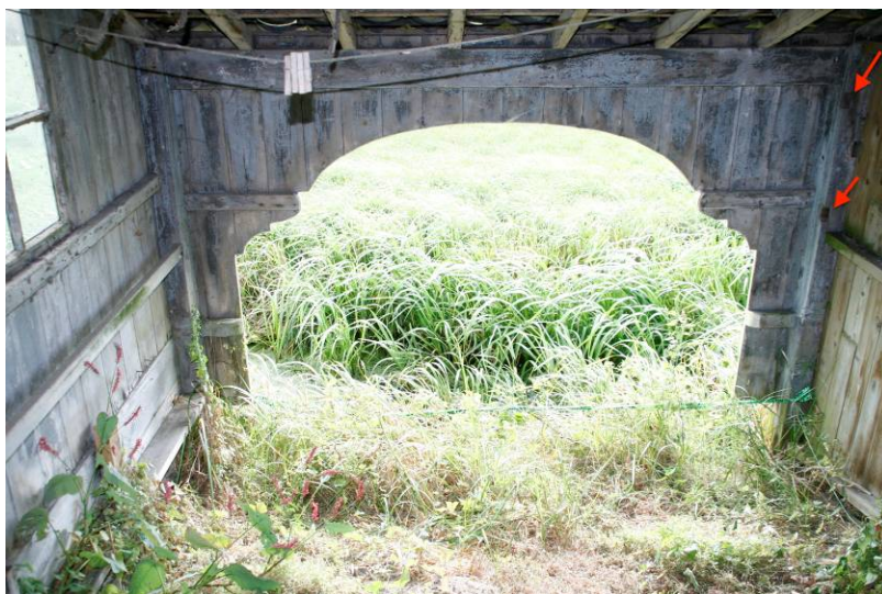
L. Het boenhok, met direct achter de opening de sloot. De pijlen wijzen naar een scharnier in de rechter stijl. In deze stijl bevinden zich verder gatverbindingen waarop de regels van de oorspronkelijke wand aansloten.
