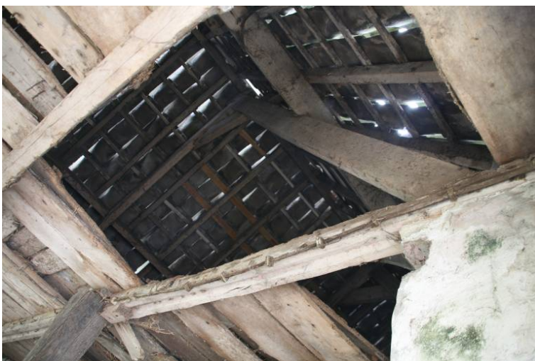
De kapconstructie van het zomerhuis bestaat uit A spanten die op beide (restanten van de) binnenmuren staan. Deze spanten dragen gordingen. De zoldering was niet toegankelijk waardoor niet kon worden vastgesteld of de gordingen aan beide uiteinden in de topgevel zijn ingelegd of door een strijkspant worden gedragen.
