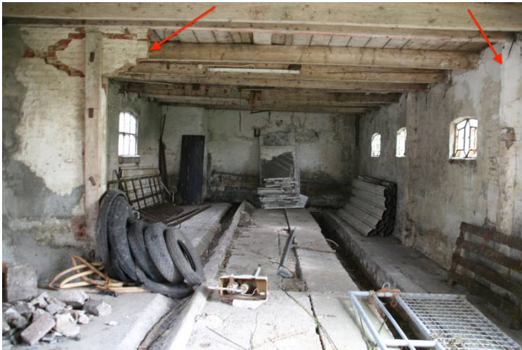
Het gedeelte van het zomerhuis achter de huidige bijkeuken, gezien naar het oosten. In de linker hoek bevindt zich de inbouw van de vanuit de bijkeuken ontsloten wc-ruimte.
