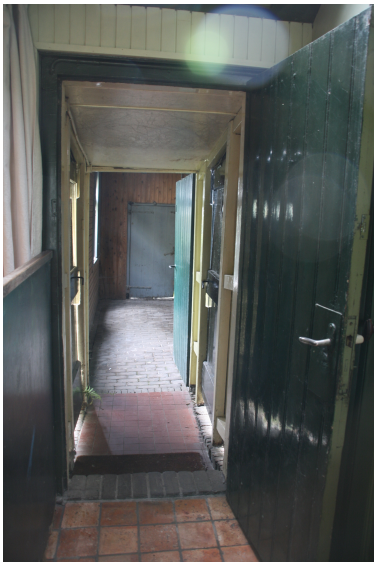
Zicht vanuit de keuken in het achterhuis van het hoofdgebouw naar het zomerhuis. Via het houten tussenlid is het voorste gedeelte van het zomerhuis toegankelijk.
