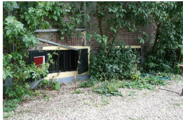
Het voorhuis, gezien vanuit het noordoosten. Onderin de noordgevel van het voorhuis zijn twee oorspronkelijke kelderlichten, voorzien van diefijzers en (dubbele) luiken.
