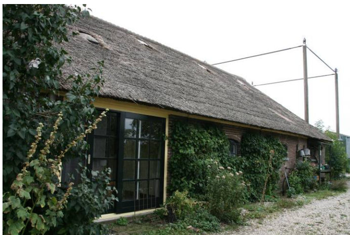
De noordelijke zijde van het achterhuis. De achterste travée van het achterhuis dateert uit 1961 toen de stal is verlengd. De pui in de voorste travée is geplaatst toen deze travée direct achter de brandmuur in 1994 6 geheel bij het woonhuis werd getrokken.
