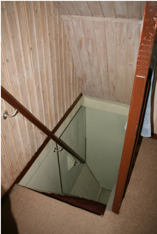
De in 1966 ingebouwde trap die de opkamer en de noordelijke zolderkamer verbindt. Het schuine houten gedeelte onderaan de trap betreft de bovenzijde van de trapopgang van de kelder naar de gang.
