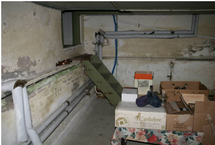
De kelder, gezien naar het zuiden.
