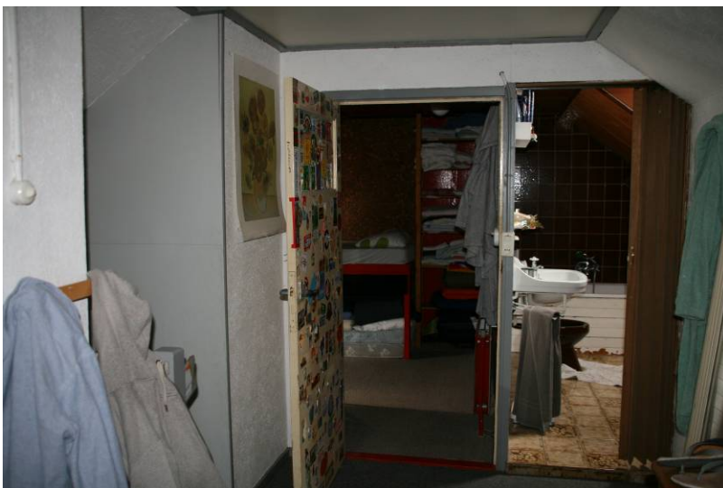
De gang op zolder van het voorhuis gezien naar de kamer en een badkamer die vermoedelijk in de jaren tachtig van de 20ste eeuw op de zolder van het achterhuis zijn ingebouwd. Links de trap naar de woonkamer.
