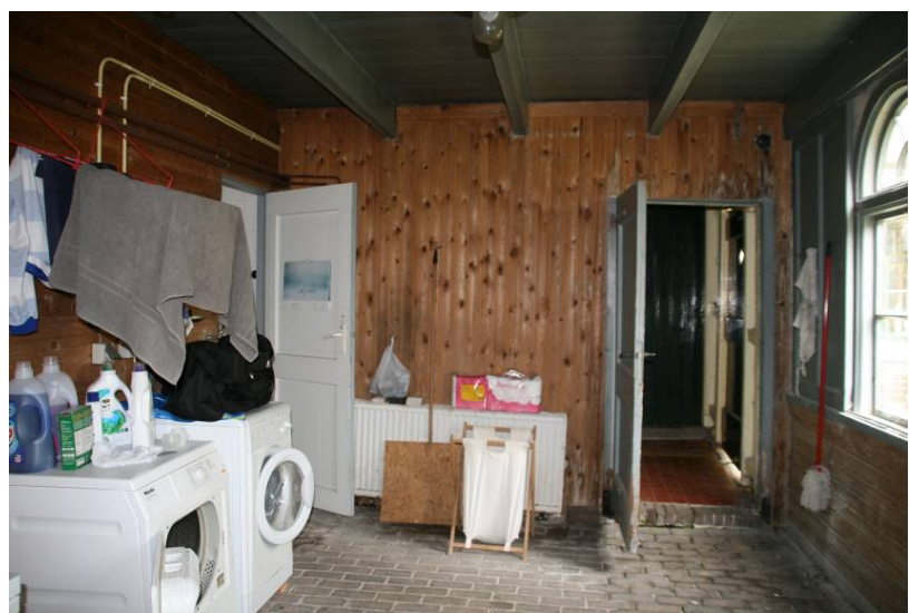
De bijkeuken, voormalige spoelruimte, gezien naar het noorden. Links de wc ruimte. De rechter deur ontsluit het tussenlid. Rechts de voorgevel met oorspronkelijk venster en schuifluik. De vloer is uitgevoerd in klinkers.
