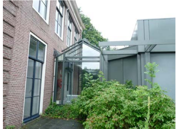
Figuur 6: Koetshuis met aanbouw van glas en plaatwerk; de voormalige laboratoria. Deze laboratoria worden gesloopt.
