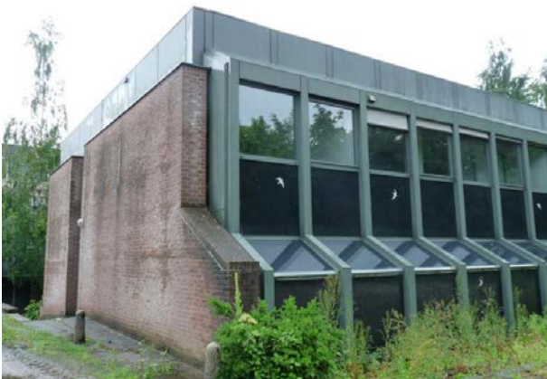
Figuur 7: Impressie van de te slopen laboratoria. Zuidzijde van het koetshuis, op de grens van het plangebied.
