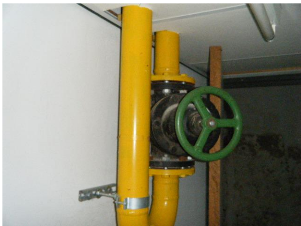
Pakking tussen flenzen van de gasleiding in de bergingskast.
