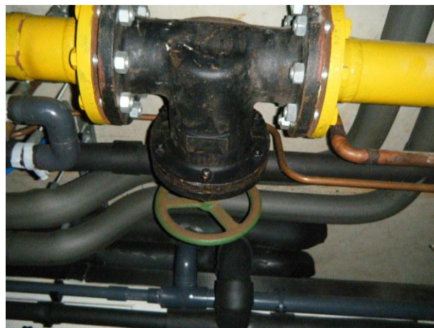
Pakkingen tussen gasleiding in laboratorium.
