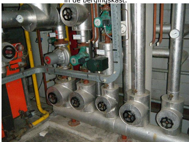
Pakkingen tussen cv leidingen in CV-ruimte.
