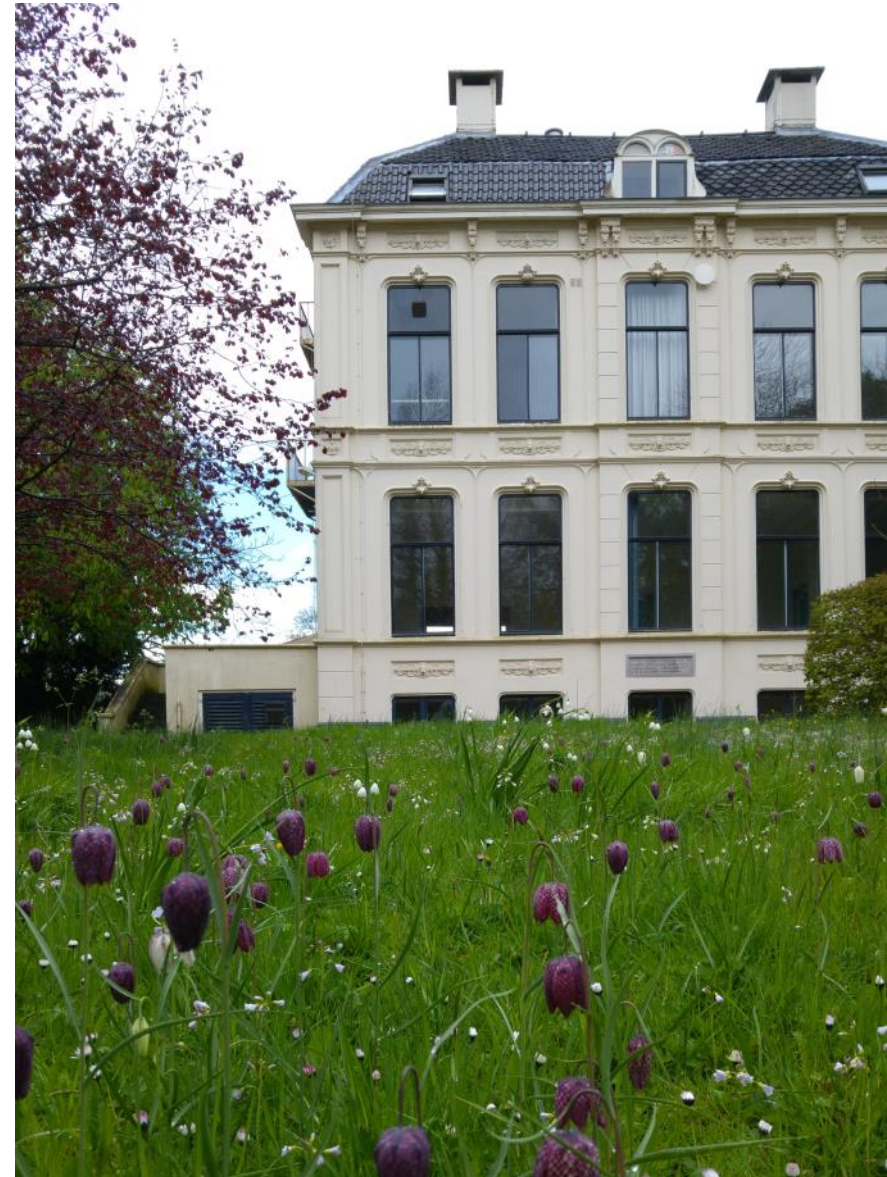
Achterkant van villa Vijverhof (foto SIA april 2016)
