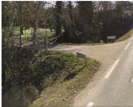
3. Dam bij de zuidelijke entree
